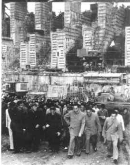
1959年10月，周恩来视察 黄河三门峡大坝工地。
